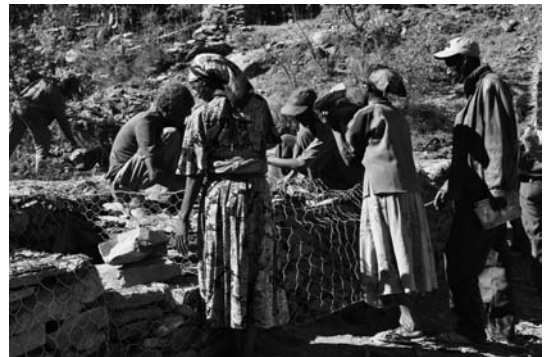
自らの手で井戸を建設する住民
